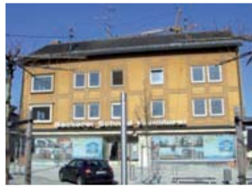
Das Gebäude vor der Sanierung
